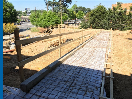
Begin Form and Pour of ADA ramp and Sidewalks
